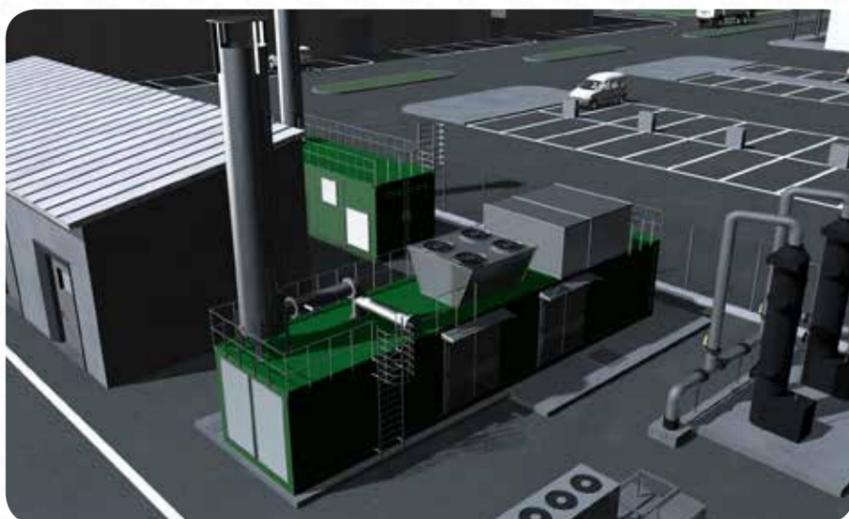
prodotta è utilizzata per gli autoconsumi ed immessa in rete quando non necessaria, mentre tutto il calore recuperato è utilizzato per soddisfare gli autoconsumi. Il gruppo di cogenerazione adottato è un motore MTU Serie Biogas da 1 MW elettrici, tecnicamente all'avanguardia e di grande efficienza (43,3 % di efficienza elettrica).
